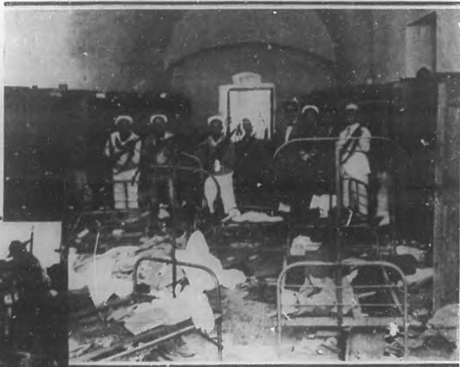
Los dormitorios de Atarés, ocupados durante una noche por los revolucionarios, muestran el desorden interior que produjo la metralla que llovió sobre aquel baluarte.
