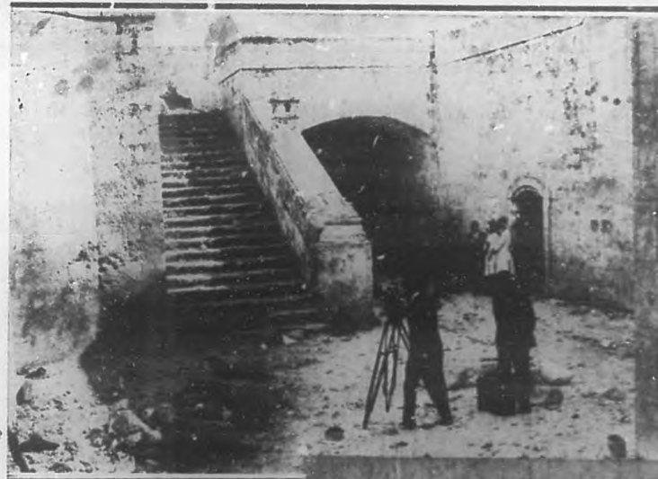
Los disparos de mortero que cayeron en los patios de Atarés, levantaron las enormes rocas de que estaba formado el piso del secular baluarte.
